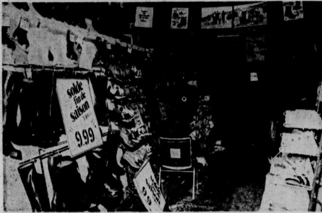
Des machines à bureau de même que des marchandises du magasin Yellow chaussures ont été endommagées par le feu, l'eau et la fumée. (Photo: L'Action-Québec — François Boulay)
