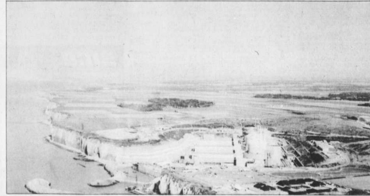
La plus récente centrale nucléaire française fait appel à la technologie mise au point par Merlin Gerin, un des sous-traitants étrangers qui ont participé à la construction de l'aluminerie de Bécancour.
