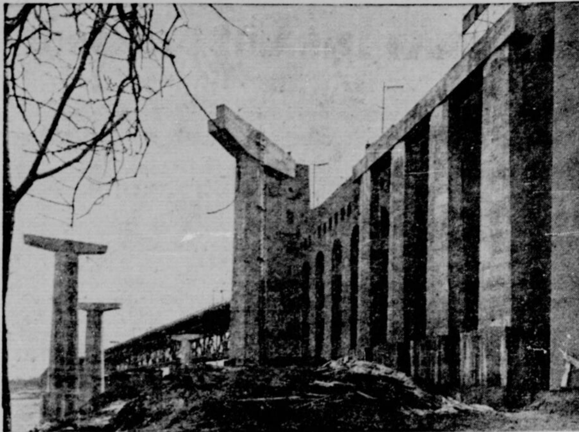
Dans quelques mois sera terminée cette nouvelle voie d'accès au pont Jacques-Cartier à la sortie de l'île Sainte-Hélène. La circulation aura tout à y gagner et, qui sait, peut-être Jacques Cartier lui-même qui, pour l'instant, est disparu de la « circulation ».
