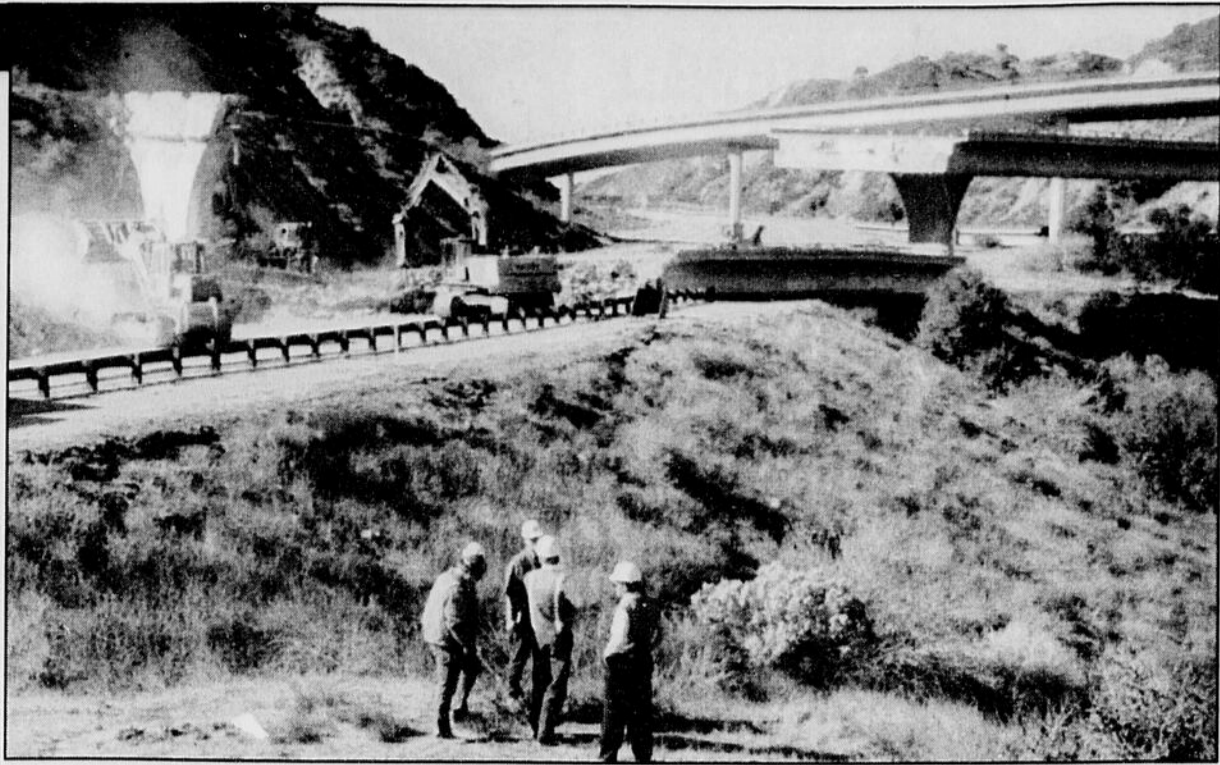
Des employés du service de la voirie californienne inspectent les dommages subis par l'autoroute 5 à Sylmar, près de Los Angeles. Cette autoroute constitue l'artère principale nord-sud de l'Etat de Californie.
