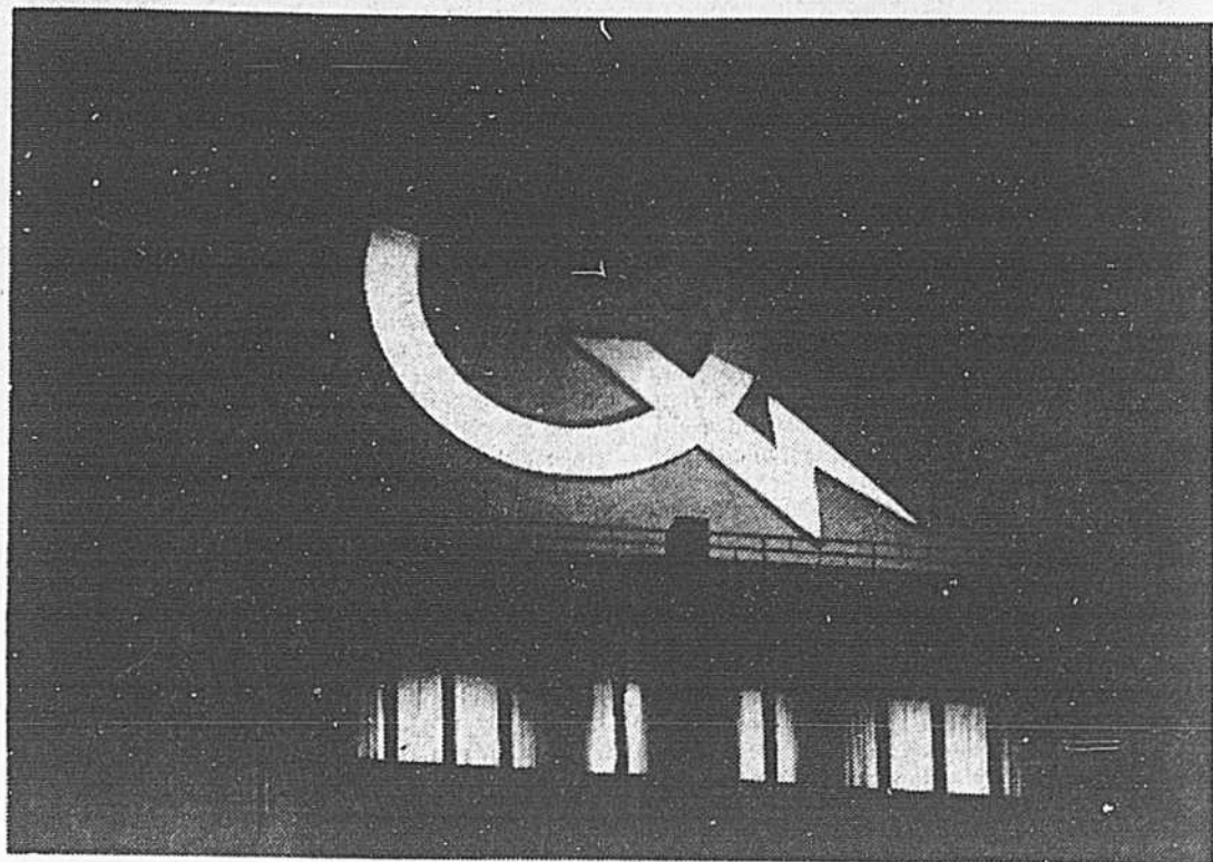
Un augure? Un signe des dieux? Un symbole? Ou un simple incident technique fortuit? Toujours est-il que tandis que le sigle géant qui orne l'une des faces de l'immeuble de l'Hydro, boulevard Dorchester, était à demi éteint (ou à demi illuminé?), le conflit, apprenait-on dans la soirée d'hier pouvait bien être au moins à demi réglé.
