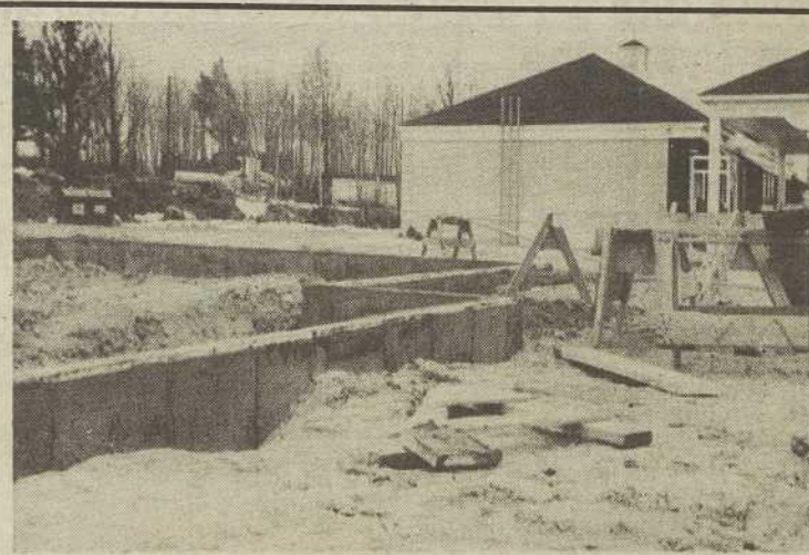
Les fondations du nouveau complexe sont déjà en place.
