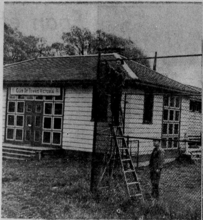
SOUS LE PIC DES DEMOLISSEURS : Le vieux club de tennis Victoria est voué à la démolition pour faire place au progrès. Depuis mardi, sur la photo de gauche, des ouvriers s'affairent à démolir ce club de tennis qui a été aménagé en 1944. Sur la photo de droite, l'emplacement prévu pour la reconstruction du club. Les plans prévoient que le club sera reconstruit sur la losange No 1 du parc Victoria.
