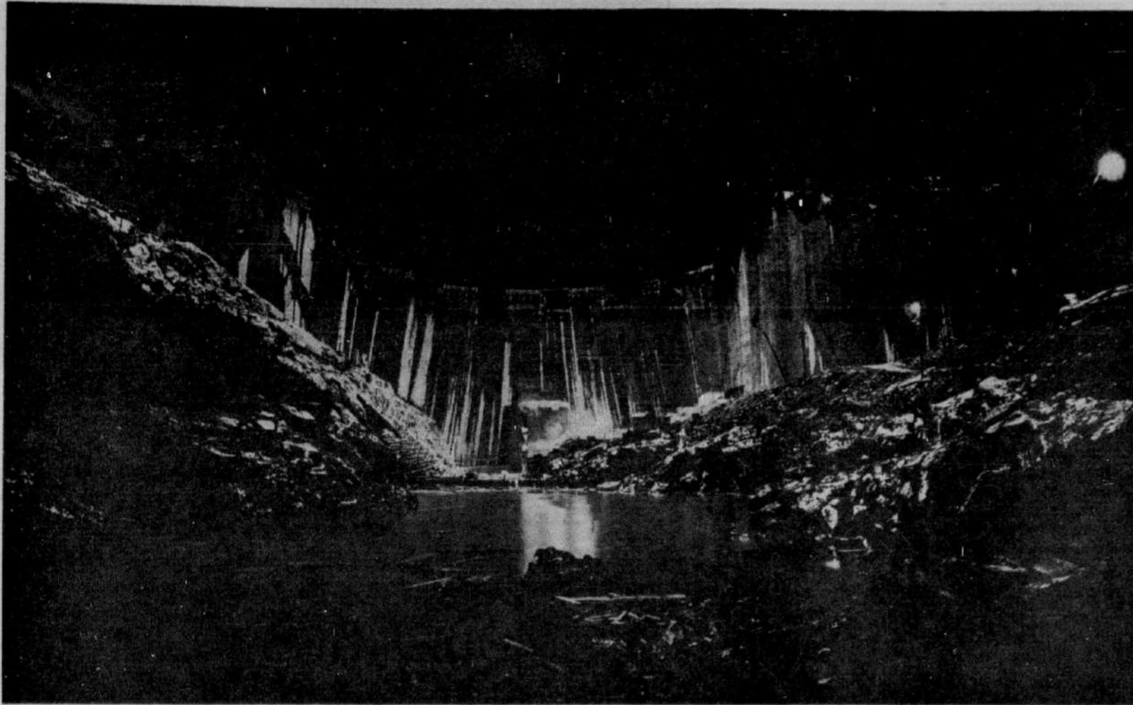
UN COIN DE LA VALLEE de la Manicouagan s'illumine pour laisser apparaître dans la nuit le barrage géant qui monte. Dans ses flancs, Manic 5 porte déjà 1,310,772 verges cubées de béton (14 octobre 1964).
