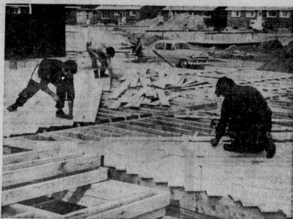
OU LA QUALITE IMPORTE — Il faut employer du bois de construction de bonne qualité pour les solives de plancher. Le faux-parquet, en plan-
