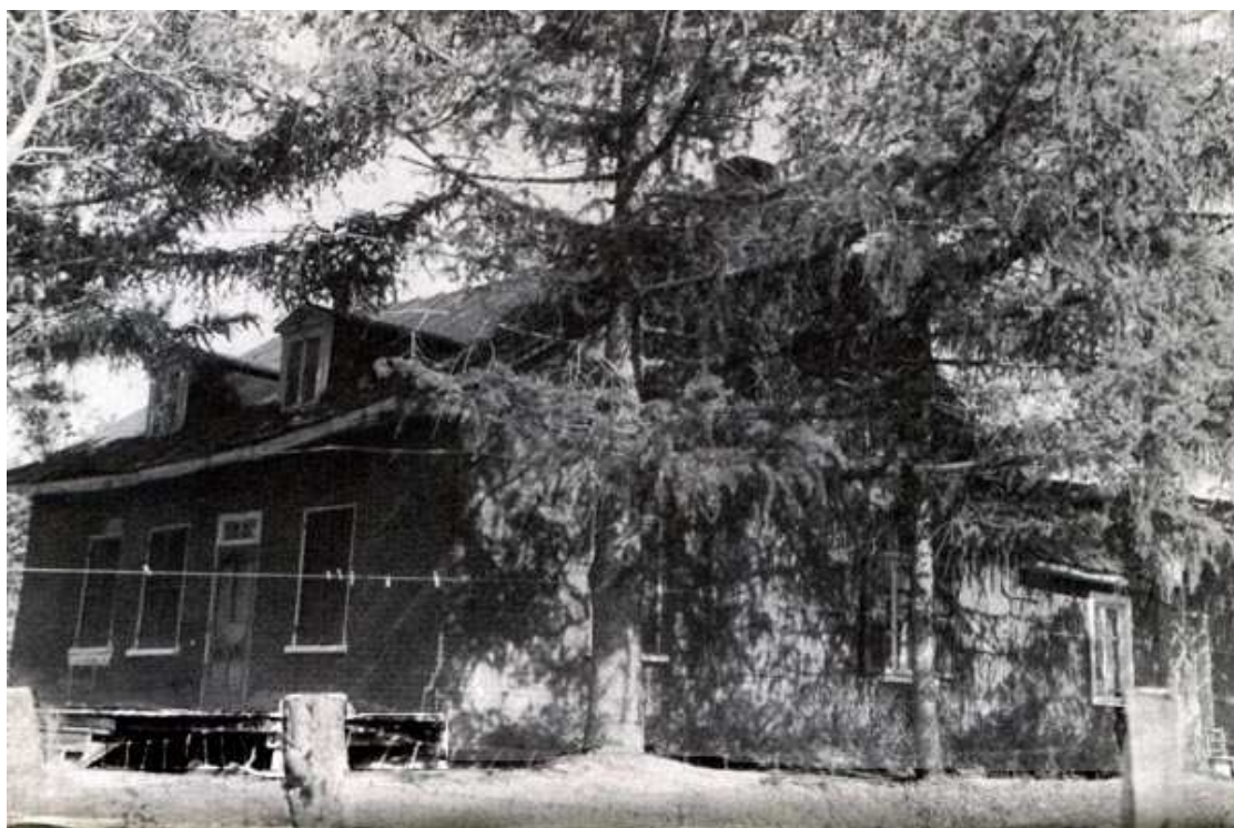
Maison natale de Léo-Paul Desrosiers à Berthier-en-Haut aujourd'hui démolie.
