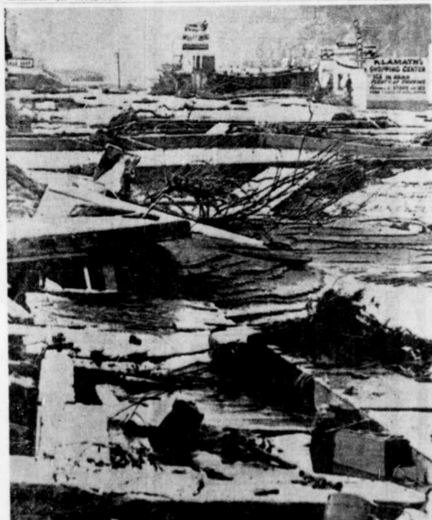
APRES L'INONDATION... — Maintenant que la rivière s'est retirée dans son lit, à Klamath, en Californie, les citoyens sont encore aux prises avec des problèmes: réparer les dégâts causés par les inondations qui ont frappé l'Ouest américain au cours des derniers jours. On sait que 44 personnes ont perdu la vie tandis que les dommages matériels sont évalués à $1 milliard. Cette rue commerciale n'est qu'un exemple du passage de l'inondation. (Telephoto PA)
