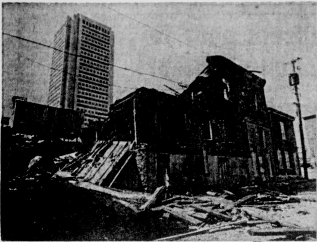
INCENDIE PRES DU PARLEMENT — Les pompiers de Québec ont travaillé d'arrache-pied pendant six heures, pour éliminer tout danger de conflagration, dans la nuit de dimanche, en combattant un incendie qui s'était déclaré près des édifices parlementaires. Deux maisons de deux étages chacune vouées à la démolition, ont été détruites et le feu a aussi lourdement endommagé une troisième maison et une roulotte. L'incendie, qui s'est déclaré vers quatre heures et s'est terminé vers dix heures, hier matin, nécessitant l'intervention de 60 sapeurs-pompiers, pourrait avoir été allumé par une main criminelle.
