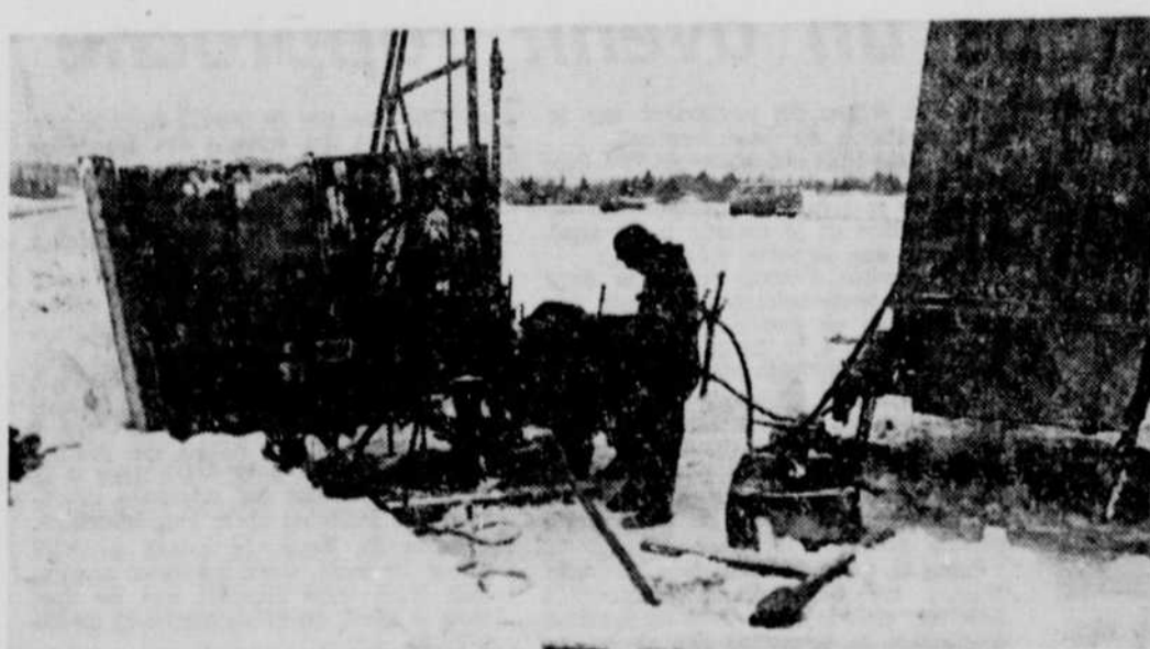
Des employés du ministère de la Voirie procèdent actuellement à des sondages près du boulevard Laurentien, à la limite des villes de Charlesbourg et Orsainville, afin de vérifier la solidité du sol. Ces travaux ont pour but de déterminer quels genres de piliers devront supporter le viaduc qui sera aménagé au-dessus du boulevard pour relier ce dernier au boulevard Jean-Talon. Le résultat du sondage permettra également de connaître avec plus de précision la date du début des travaux, qui pourraient, selon certains observateurs, entraîner des dépenses de $1.5 million. (Photo l'Action-Québec)
