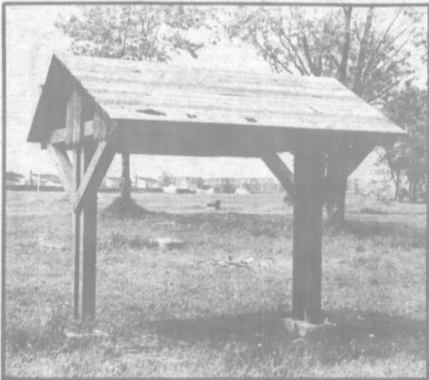
Mis à part quelques planches, il ne reste pas grand chose des équipements de la halte de la Côte de Terrebonne. Les vandales y ont détruit tables de pique-nique, fours à charbon de bois et même... les poubelles! (Photo, LA REVUE)
