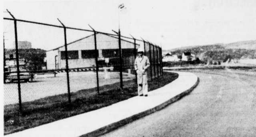
CEINTURER LES SERVICES PORTUAIRES de la division du Transport de SECAL à Ville de La Baie d'une clôture sécuritaire sur tout le territoire, c'est là un projet de deux ans. Jusqu'ici, les travaux ont progressé admirablement bien. Il ne reste plus à compléter que le long de la rive, immédiatement à l'est des écrans anti-poussière, de même qu'un tronçon situé au ponceau no 3 du Roberval Saguenay. On voit sur la photo, la partie encerclant le stationnement.
